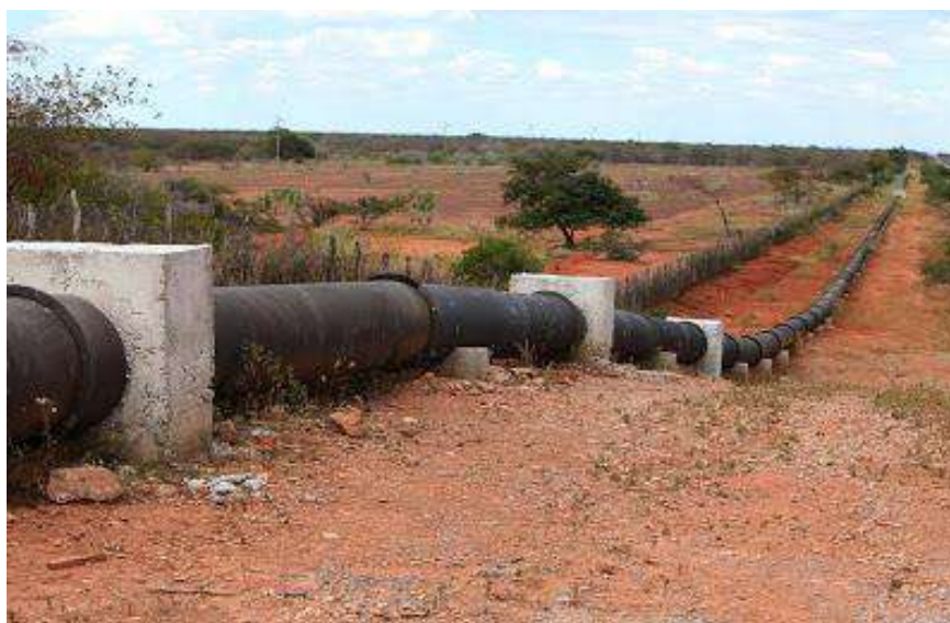
Figura 25 - Adutora do São Francisco
