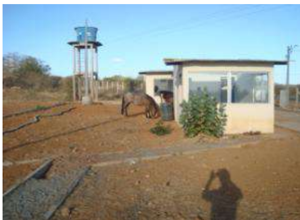
Figura 78– Estrutura do Aterro Regional
