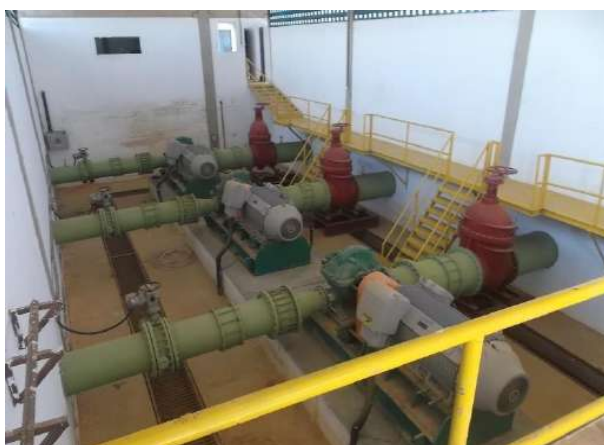
Figura 27 - EEAT 4A. Detalhe do Barrilete
