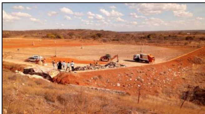
Figura 97 - Aterro Sanitário de Irecê em início de operação
