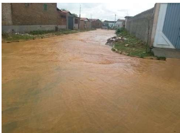
Figura 49 - escoamento de águas pluviais em Irecê
