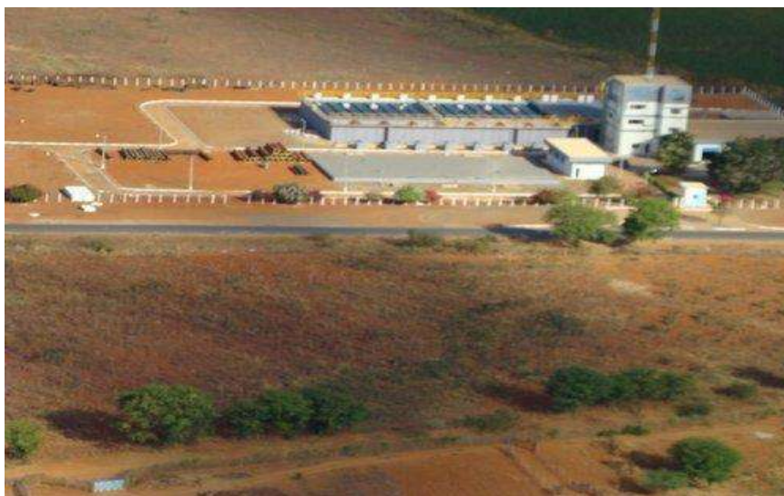
Figura 24 - Vista aérea da ETA de Ibititá - Sistema do Feijão
