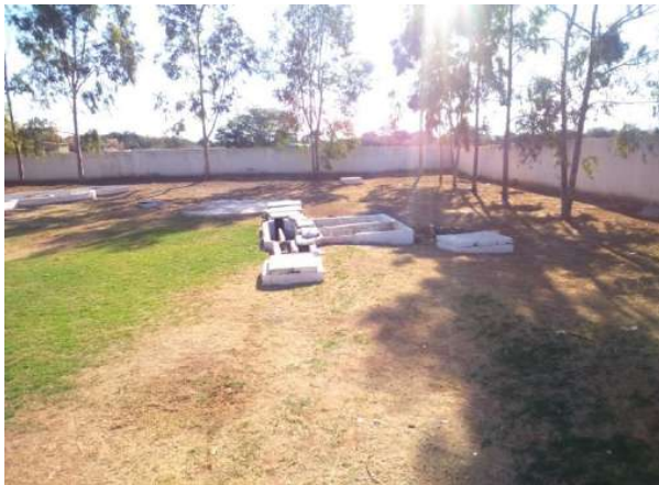
Figura 39 - ETE Fundação Bradesco
