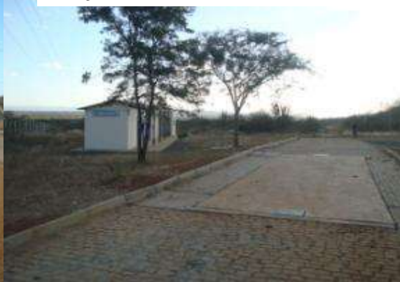
Figura 79– Estrutura do Aterro Regional - Balança
