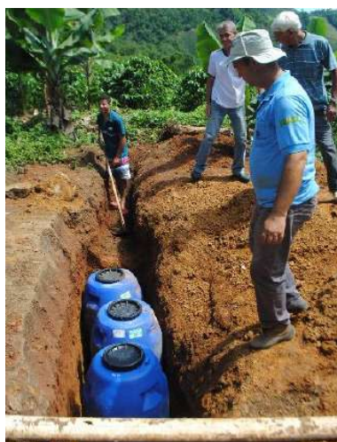
Figura 87 - Instalação de fossas sépticas econômicas
