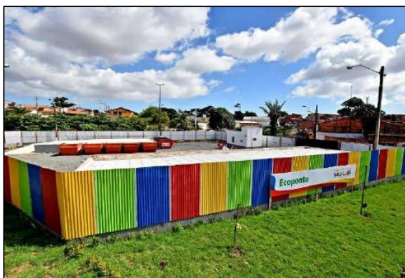
Figura 91 - Ecoponto São Luis-MA, recebem resíduos recicláveis secos, volumosos e até RCC
