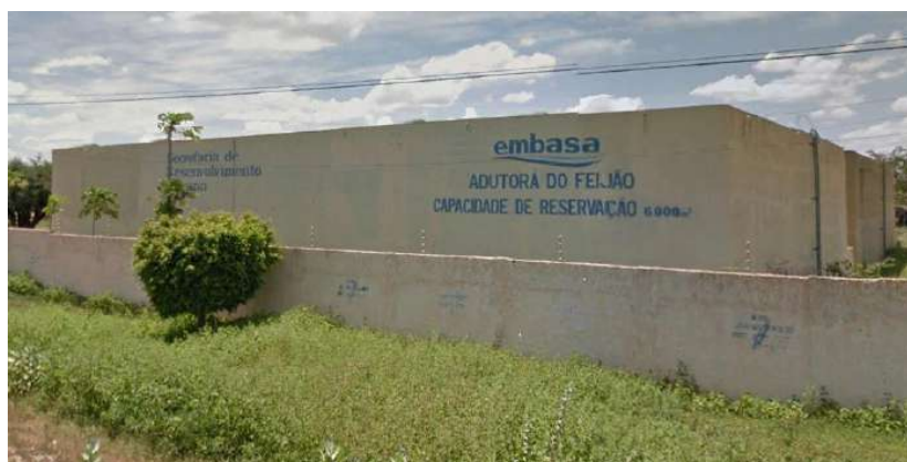
Figura 33 - Reservatório apoiado com capacidade de 6000 m³
