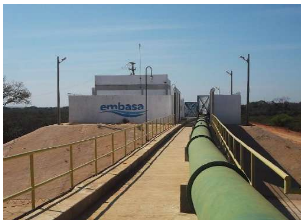
Figura 21 - Estação Elevatória de Água Bruta (EEAB-1A)
